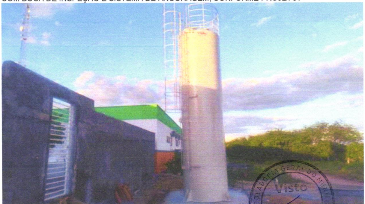
FOTO 26 - RESERVATÓRIO DE CHAPA DE AÇO CARBONO E SOLDA INTERNA E EXTERNA, COM BOCA DE INSPEÇÃO E SISTEMA DE ANCORAGEM, CONFORME PROJETO.
